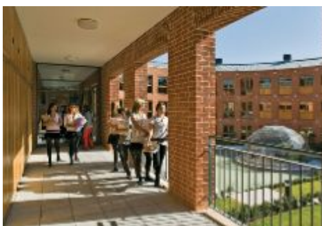
Εικ.4.4:Στεγασμένος υπαίθριος διάδρομος σε σχολικό κτίριο.
