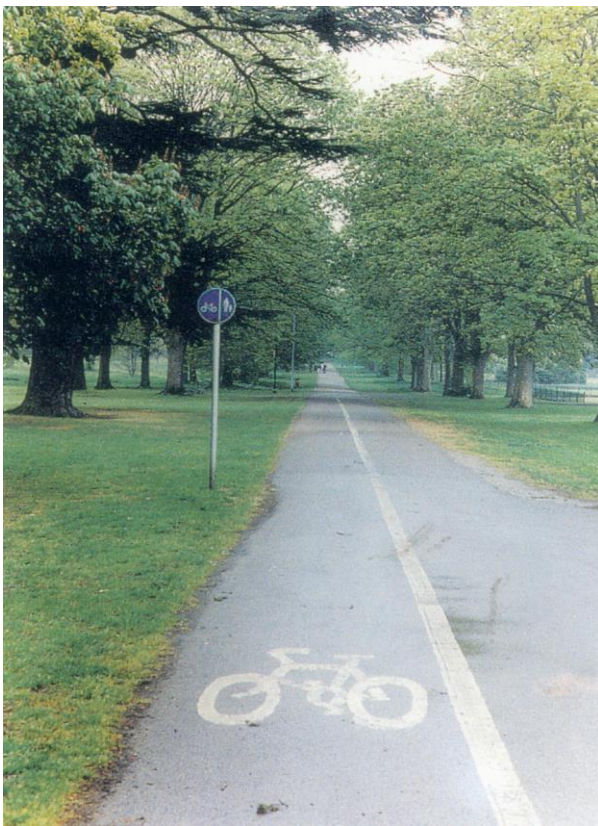
Εικόνα 11: Ανεξάρτητος διάδρομος με διαχωρισμό της επιφάνειας κίνησης των ποδηλάτων και των πεζών.
