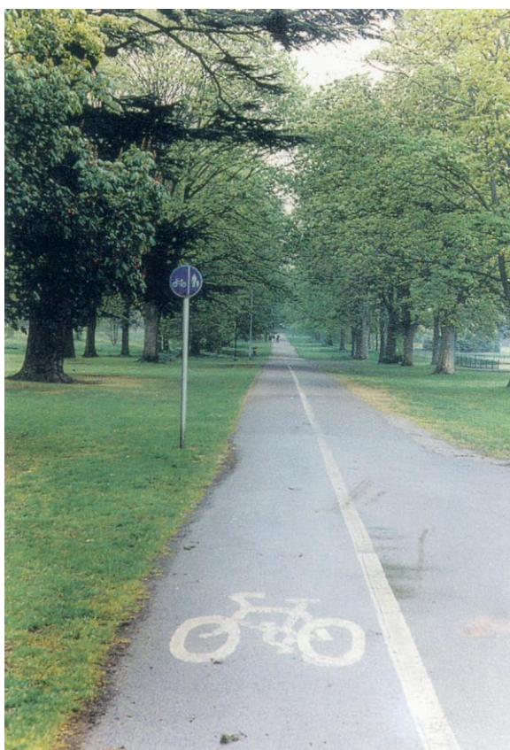
Εικόνα 10: Ανεξάρτητος διάδρομος με διαχωρισμό της επιφάνειας κίνησης των ποδηλάτων και των πεζών.
