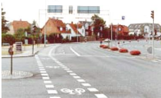
Εικόνα: 24 Διάβαση ποδηλάτου με οριοθέτηση από διακεκομμένη γραμμή.
