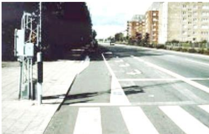
Σχήμα: 3 Συνοδευτικός ποδηλατόδρομος σε διασταύρωση.
