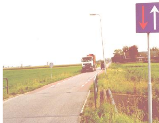
Εικόνα 21: Λωρίδες μη αποκλειστικής χρήσης σε περιοχή υπαίθρου και στις δύο πλευρές της οδού.
