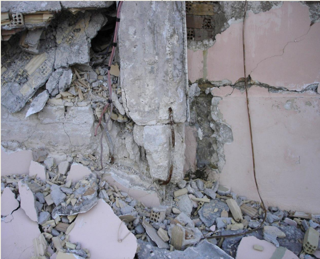
Απουσία συνδετήρων στη βάση και διακοπή συνέχειας του υποστυλώματος, από το στερεό εγκιβωτισμού του δαπέδου.
