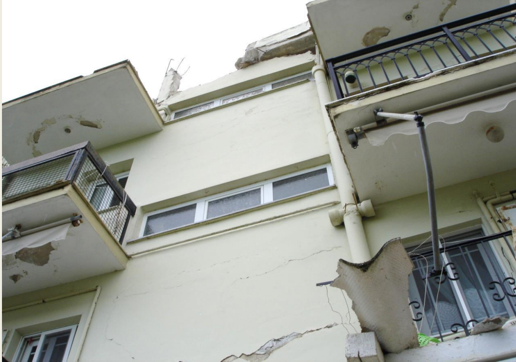
Ανεπαρκής αγκύρωση διαμηκών οπλισμών και απουσία συνδετήρων στην κορυφή του υποστυλώματος.
