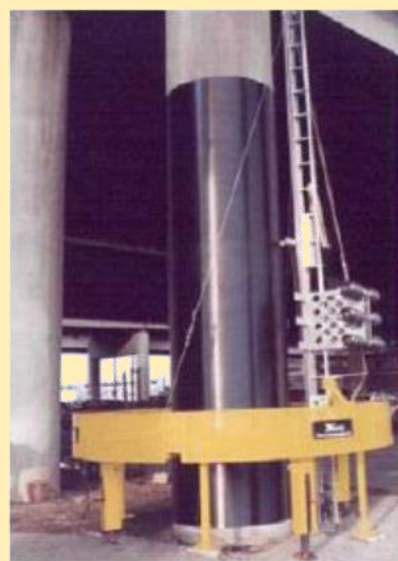
Συσκευή ρομπότ αυτοματοποιημένης περιτύλιξης προεμπτισμένων νημάτων.
