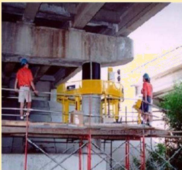
Συσκευή ρομπότ αυτοματοποιημένης περιτύλιξης προεμπτισμένων νημάτων.
